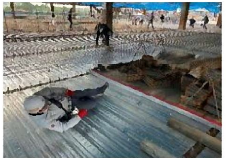
床スラブ・フラットデッキ(鋼製型枠材)
