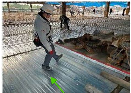
床スラブ・フラットデッキ(鋼製型枠材)
