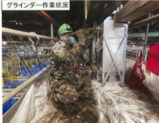
グラインダー作業状況
